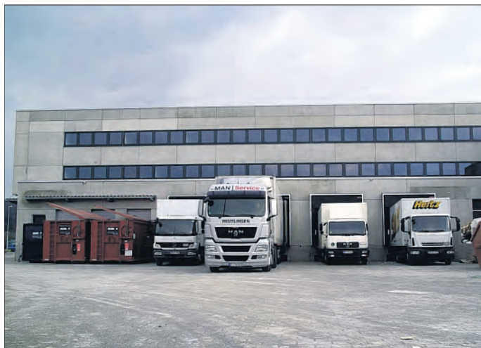
Neben der Zentralküche wird demnächst auch das Zentrallager des Universitätsklinikums nach Weilheim verlegt werden.
