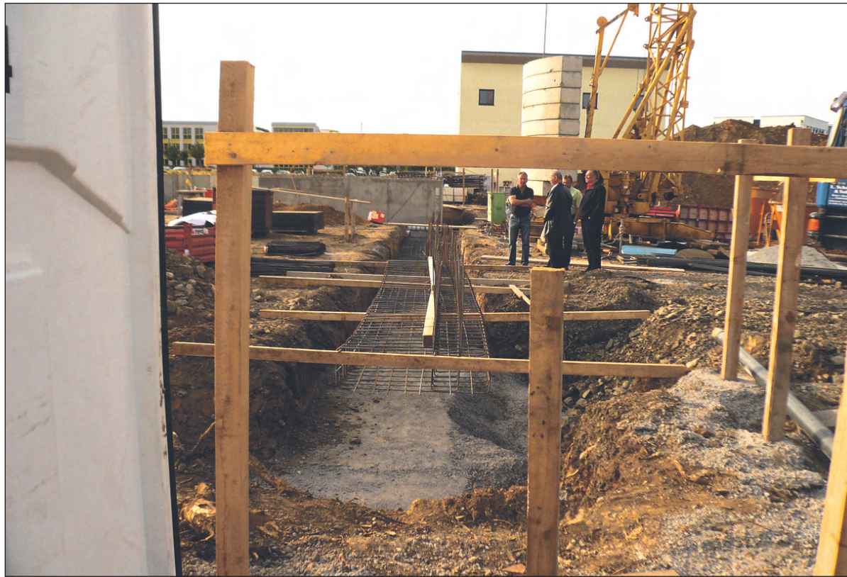
DIE BAUARBEITEN FÜR das neue Catering-Centrum sollen im Herbst 2008 abgeschlossen sein.
