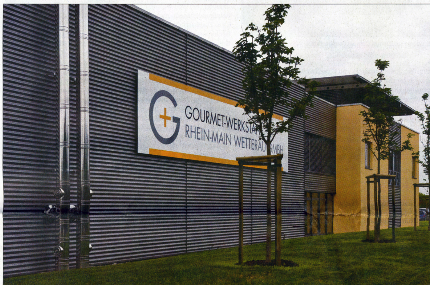
IN DER GOURMET-WERKSTATT werden die Speisen nach dem Cook & Chill-Verfahren produziert. Fotos: GZ Wetterau
