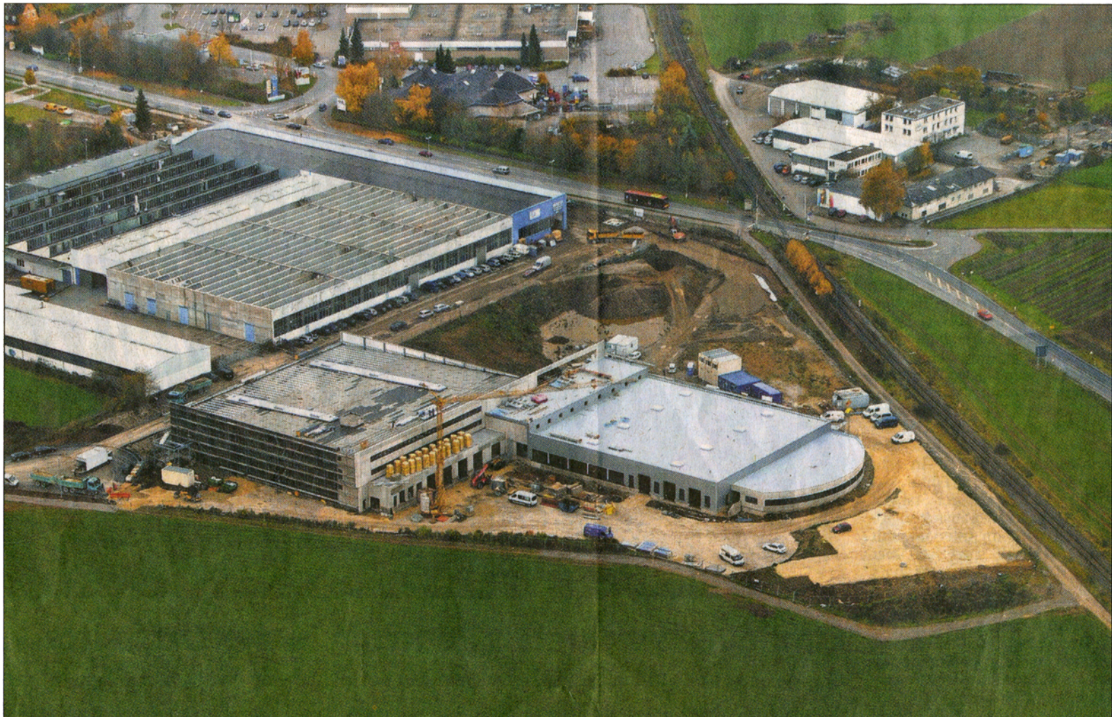
Nicht nur am Tübinger Uniklinikum selbst wird gebaut und geplant. Auch bei der 51-prozentigen Klinikums-Tochter U.D.O. tut sich was: Im Dezember soll die neue Großküche in Weilheim fertig sein. Vom kommenden Jahr an werden von hier aus Patienten in Berg- und Tal-Kliniken mit Essen versorgt. Luftbild: Grohe
